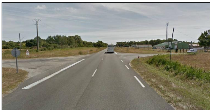
Le carrefour entre la RD 1215 et la zone artisanale de Pingouleau (à droite)
